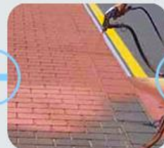
Нанесение цветного защитного покрытия
