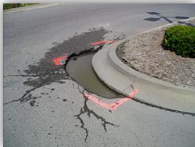
1. Наметить и очистить участок от мусора и воды
