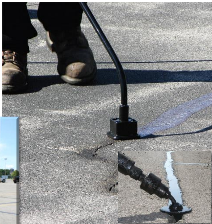
Заливка трещин и швов на асфальте ручным способом
