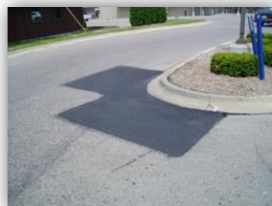
6. Вид асфальта после проведенных работ
