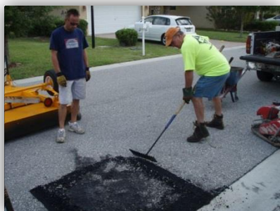
3. Перемешать граблями размягченный асфальт, устраняя ямы и неровности
