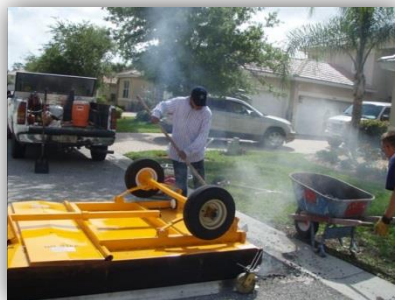
2. Разогреть асфальт инфракрасной установкой от 5 до 9 минут
