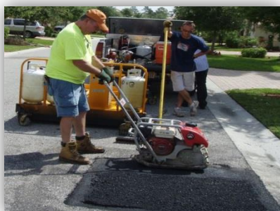
5. Уплотнить перемешанный асфальт до необходимой степени
